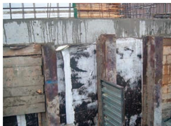
後打ちコンクリートに密着しているガスファルト先やり防水層 (GAM-3L工法) の様子
